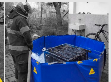
Hašení poškozeného bateriového úložiště FVE
